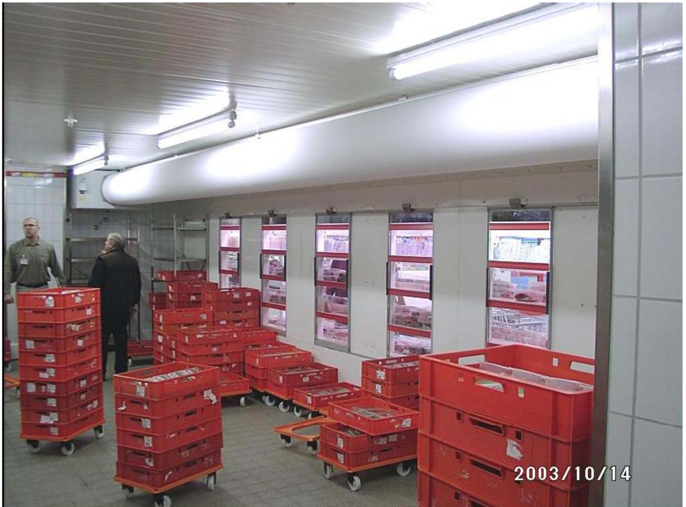
Вид из мясного цеха, обращенного к распашным дверкам горок Methos с задней загрузкой. Вытяжка под потолком, присоединенная к испарителям позволяет избежать сквозняков в цеху.
