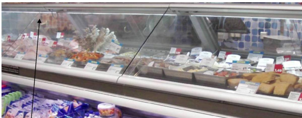
Полнопрофильный делитель (опция). Герметичное разделение обслуживаемого пространства на зону выкладки свежей рыбы и зону демонстрации готовых деликатесов из мяса или рыбы.
