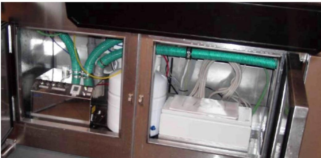
Установка системы увлажнения (GOL-2 или GOL-3) со шлангами и распылителями (опция) в запаснике. Перед резервуаром монтируется фильтр тонкой очистки воды.
